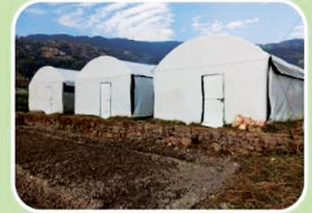
आधुनिक टनेल निर्माण
