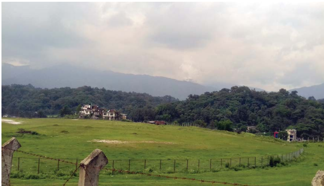
अन्तराष्ट्रिय स्तरको क्रिकेट मैदान तथा क्रिकेट एकेडेमी (निर्माण स्थल)
